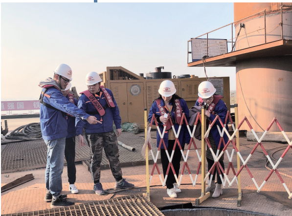
青安岗检查工地。
