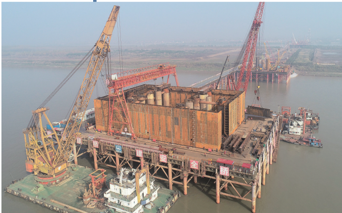
4#墩底节围堰拼装。
