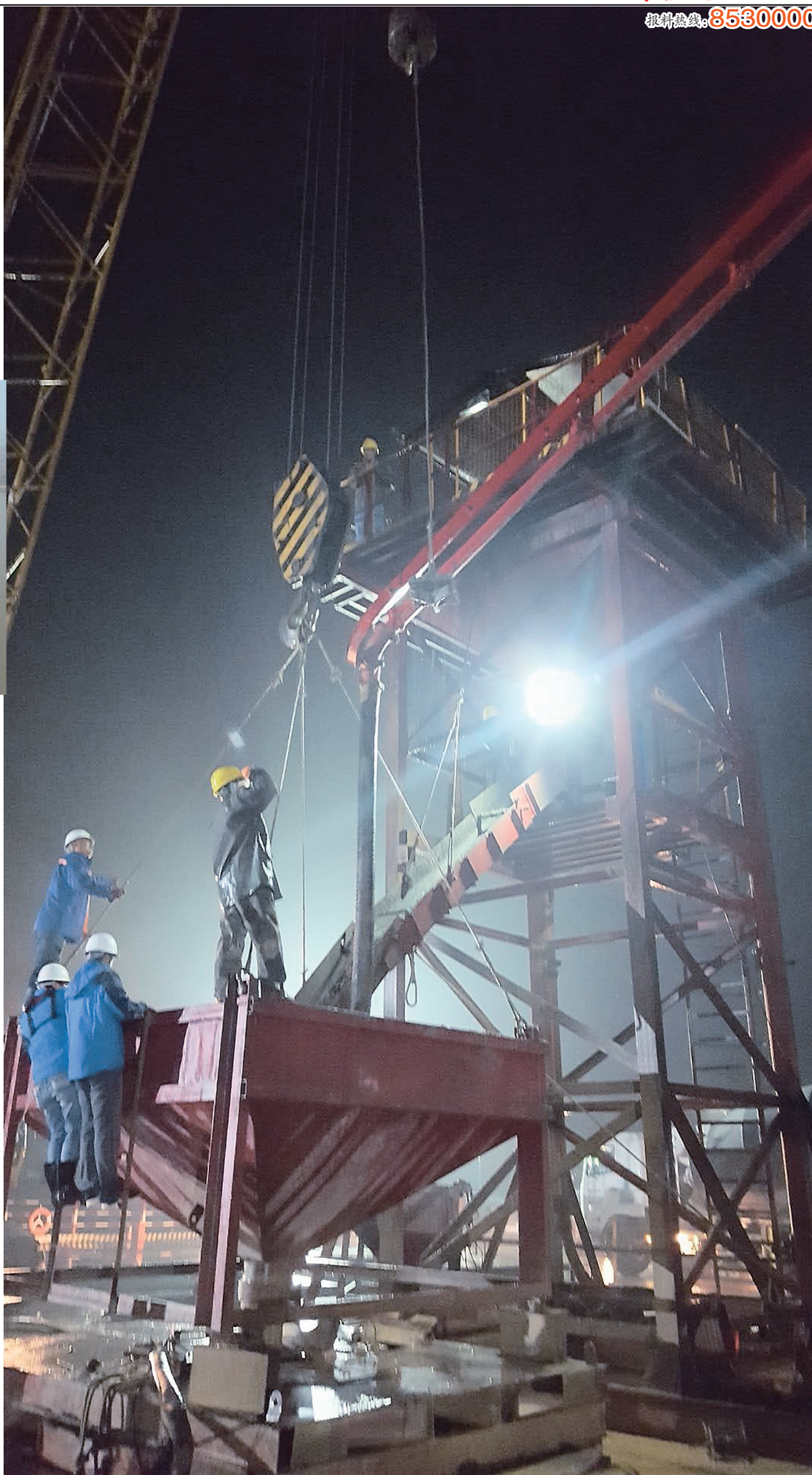
夜间加紧施工。
