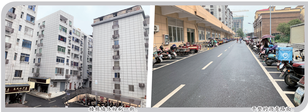
楼栋墙体粉刷一新。
