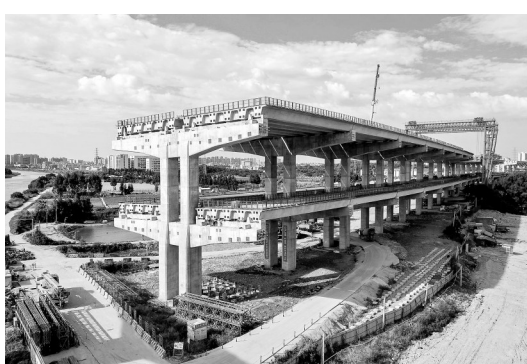
这是9月27日拍摄的莞番高速双层桥梁施工现场。
