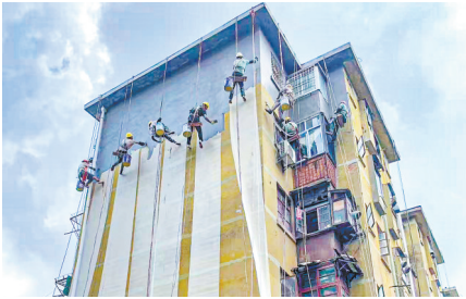
工人正在施工。
