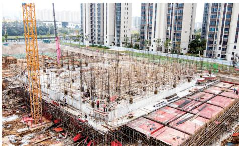
近日,在八里湖新区农产品批发市场项目建设现场,钢筋捆扎、水泥浇筑、脚手架搭建等多种施工作业正在同步开展。该项目位于尚德路以南、九龙山以东、昌九高速以北,建筑面积约9754平方米,主要建设一栋5层高标准智慧农贸市场,配套建设约9200平方米的地下室。目前,整个项目按计划稳步推进,力争明年3月份建成投用。(本报记者 刘家 摄)
