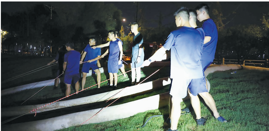
队员们正在架设排涝管道。(段昕誉 李灿/摄)
